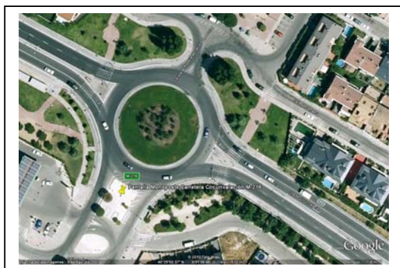
Isleta de Calle la Presa con Glorieta Rosalía de Castro en Carretera de circunvalación, Carretera M-216.
