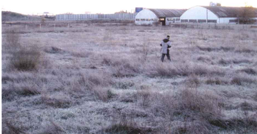
Vista de la zona sur y central del área de actuación.
