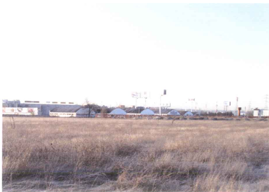
Vista de las edificaciones en la zona de actuación.
