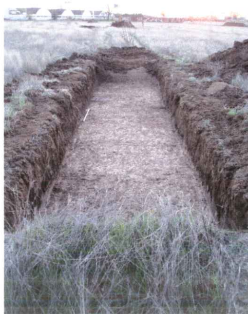
Sondeo 8. Vista sur.
