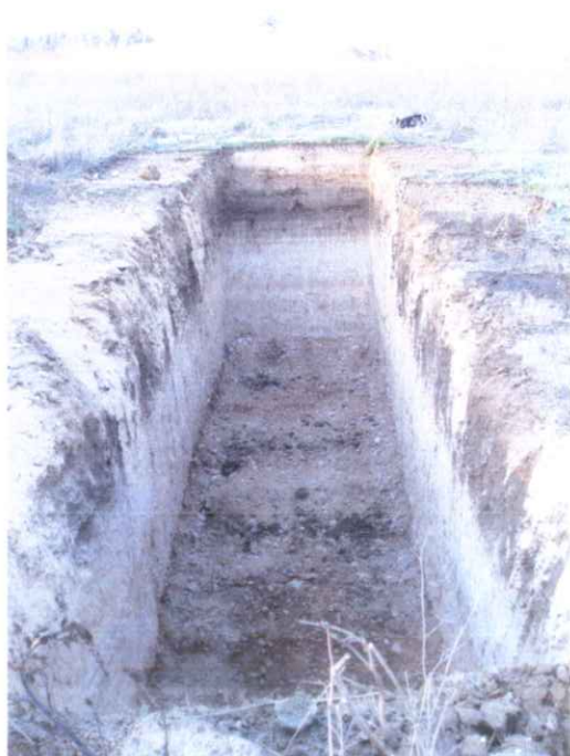
Zanja/trinchera 2. Vista norte.
