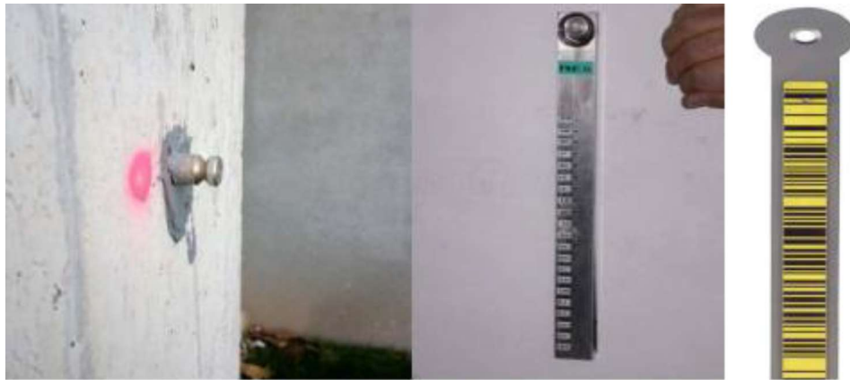
Figura 18: Regleta de nivelación, con diábolo de soporte instalado en fachada.
